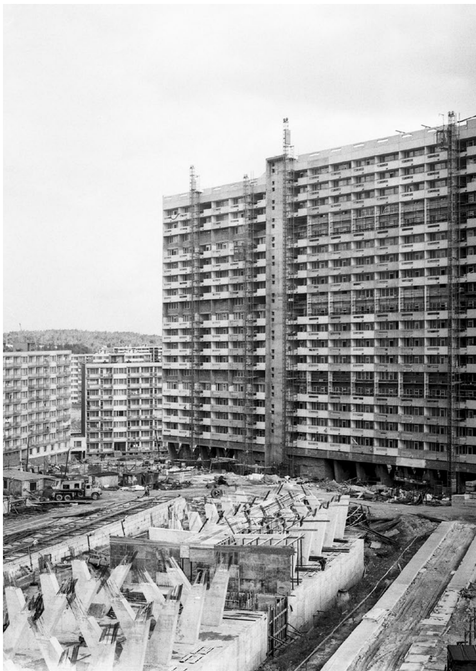
Výstavba výškových domů na sídlišti Březenecká, rok 1975
