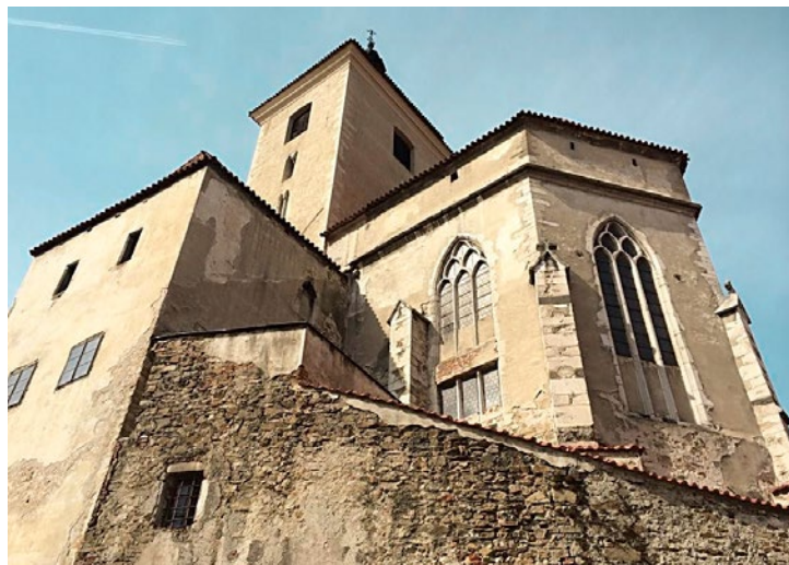
Strakonice, kostel sv. Prokopa v areálu hradu. Ochoz nad korunní římsou ukazuje, jak mohla původně vyhlížet situace i v Chomutově.
