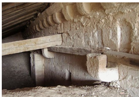
Příklady využití vnitřních konzol pro středověké krovy
