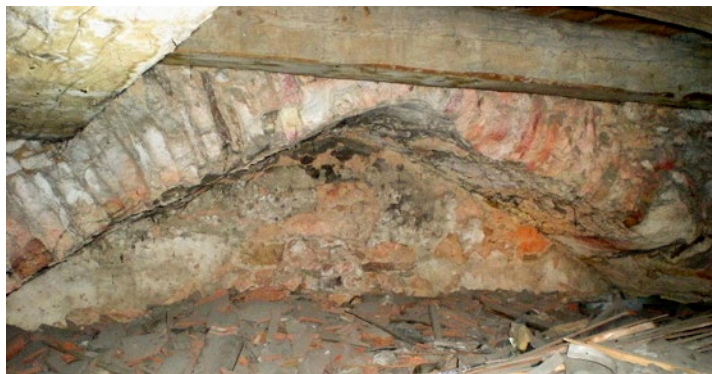
Kostel sv. Kateřiny – západní zarděný oblouk presbyteria v prostoru půdy. Ukazuje na záměr pokračování přestavby kostela ve výškové úrovni presbyteria.
