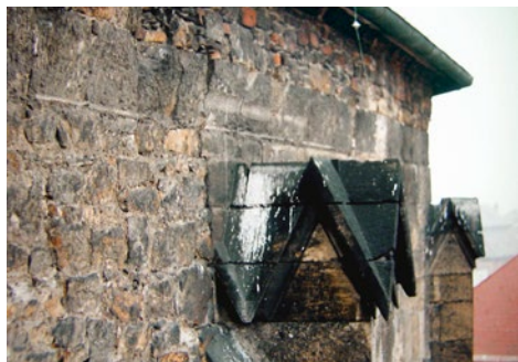
Kostel sv. Kateřiny – nejlépe zachovaný úsek profilované korunní římsy na jižním průčelí nad opěrným pilířem
