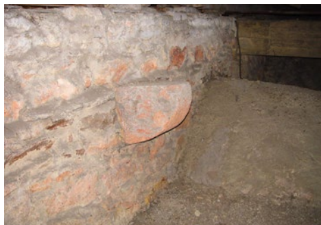
Kostel sv. Kateřiny – vnitřní pískovcová konzola nad klenbou v prostoru půdy
