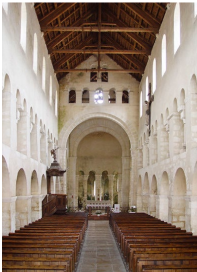
Kostel Saint-Étienne ve Vignory, Francie – pohled do otevřeného krovu v interiéru kostela
