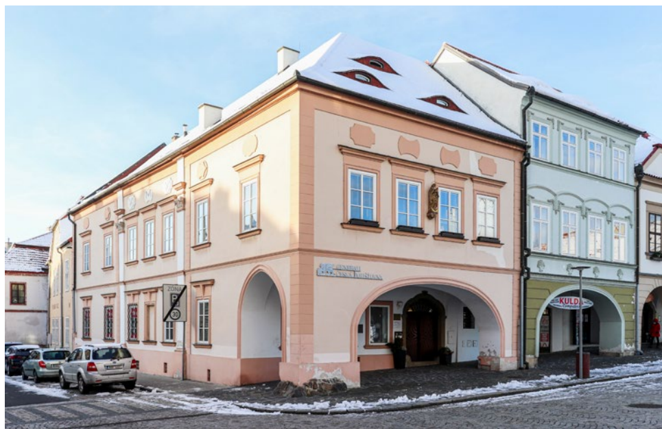
Fotografie domu č. p. 115 na náměstí v Kadani, 2023
