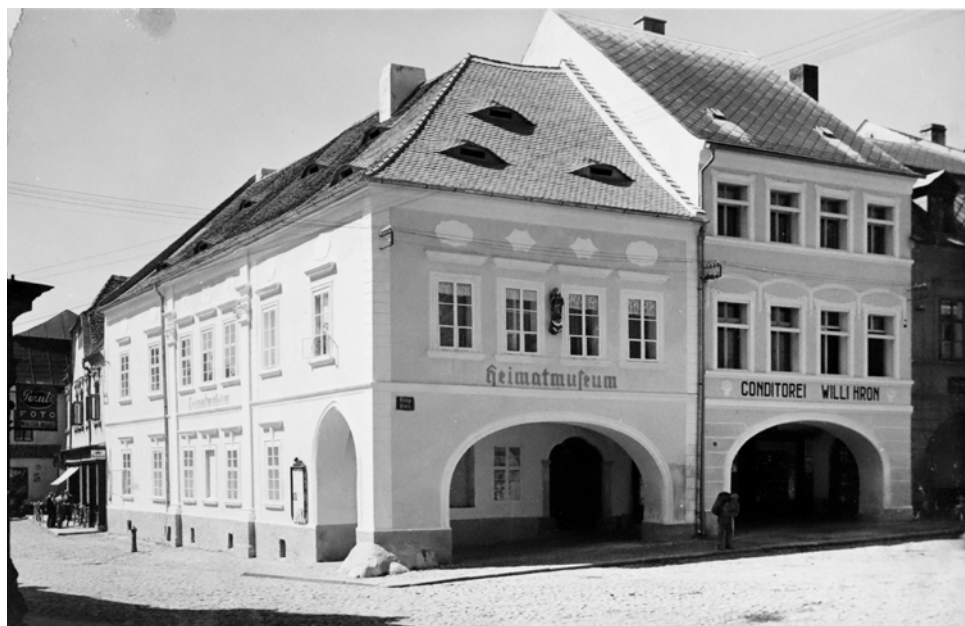
Fotografie domu č. p. 115 na náměstí v Kadani, 1935
