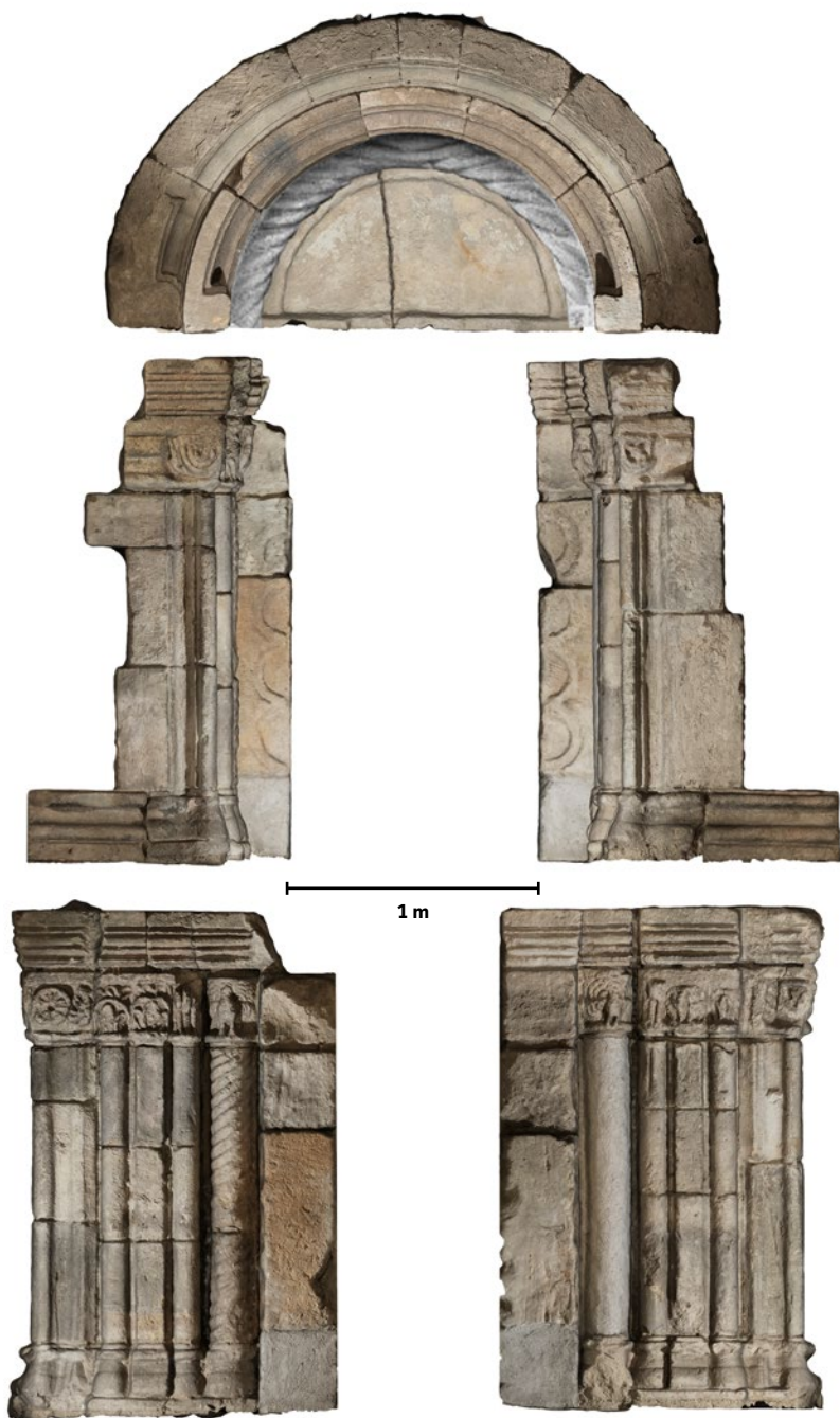
10 Fotogram portálu vytvořený metodou Structure from motion a sesazený podle fotografií stavu před zbořením kostela. Tordovaný oblouk nebylo možné zřepředu vyfotit, dosazen ze starých fotografií. Vnější oblouk bylo nutno lehce roztáhnout – patrně byl znovu sestaven nepřesně.
