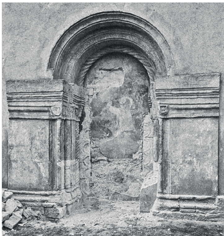
5 Pohled na jižní stěnu kostela s detailem portálu v původním umístění, rok 1965 zdroj: NPÚ
