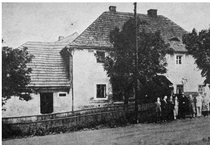
Budova fary čp. 210 před rekonstrukcí, před rokem 1943 foto: archiv autora
